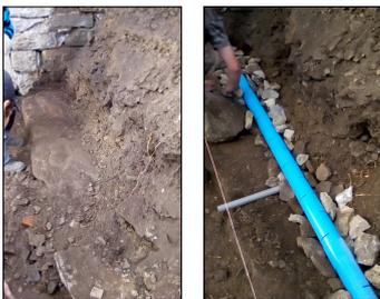
Le mur de soutènement : on a démolé le mur de soutènement existant, on a trié les pierres, d'un côté les petites et de l'autre les grosses. Pour plus de sécurité on a drainé le fond du mur puis on a reconstruit en pierres sèches.
