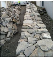
Après 15 jours d'acharnement, vient la phase de finition afin d'avoir un dessus de mur le plus lisse possible. On recouvre alors le mur de pierres plates et on s'émeut devant la forme géométrique naissante.
