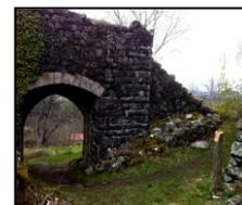
La restauration de murs en pierres a été soignée, en effet on a évité le « coup de sabre », c'est à dire une faille entre des pierres superposées sans chevauchement qui risque d'être un point de rupture dans la construction et une voie d'infiltration des eaux. »
